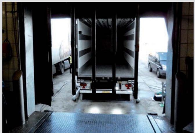
Bild 5: Ansicht von innen. Das Rolltor ist geöffnet, und der LKW setzt rückwärts an die Laderampe heran. Rechts und links neben dem LKW die „Führungrohre“ erkennbar
