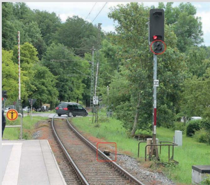
Bild 1: Hauptsignal mit Zusatzsignal („Ersatzsignal Zs 1“ im roten Kreis) und Gleismagnet für die Zugsicherung (rotes Quadrat)
